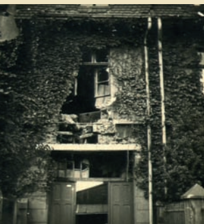
„Nur“ Sachschaden war am Hause Am Beisenkamp 23 entstanden.
