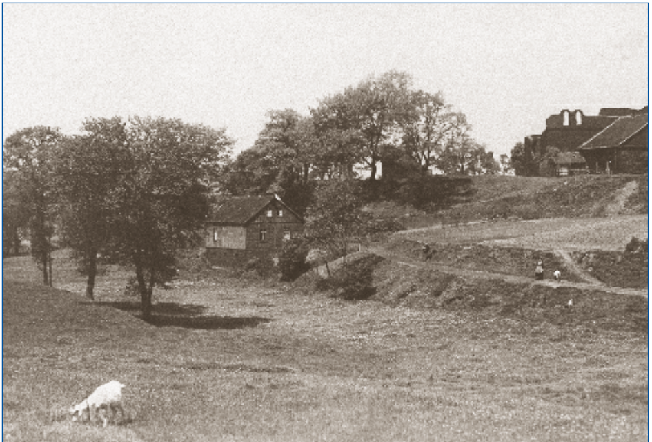
Talstraße Blick auf Schacht Hektor; Foto: Stadt Bochum
