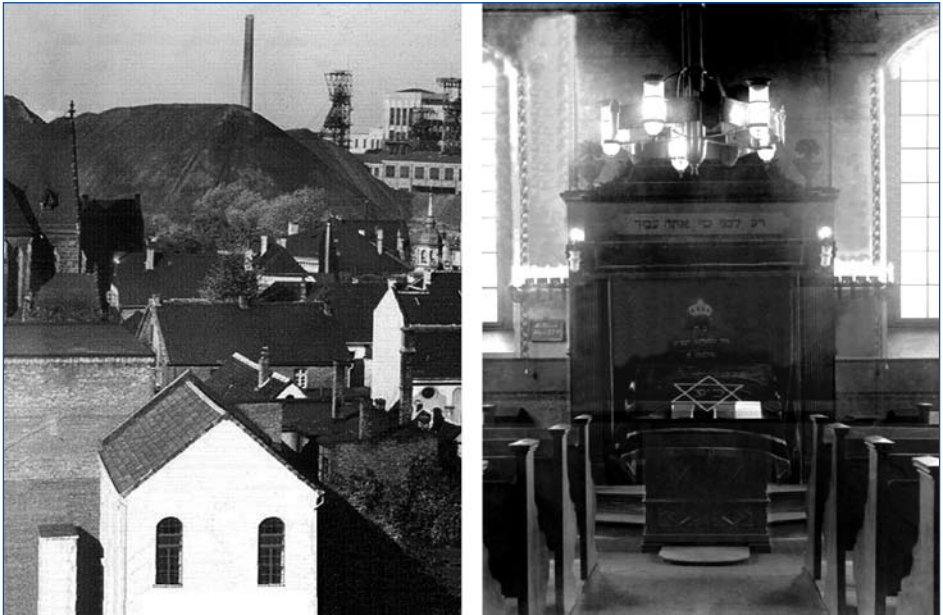
Die damalige Wattenscheider Synagoge 1931 (Außen- und Innenansicht); Foto: Sammlung Wantoch
