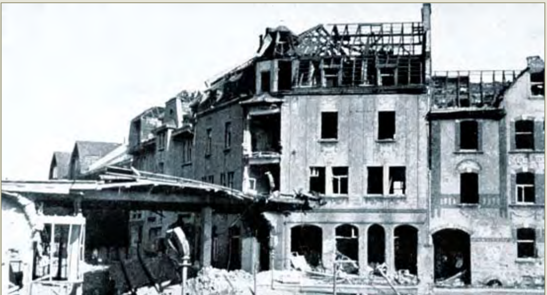
Kriegsschäden an der Bochumer Straße; Sammlung Wantoch
