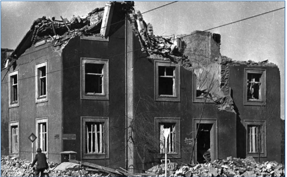
Ecke Bochumer Straße / Freiligrathstraße; Bild: Fritz Riedel
